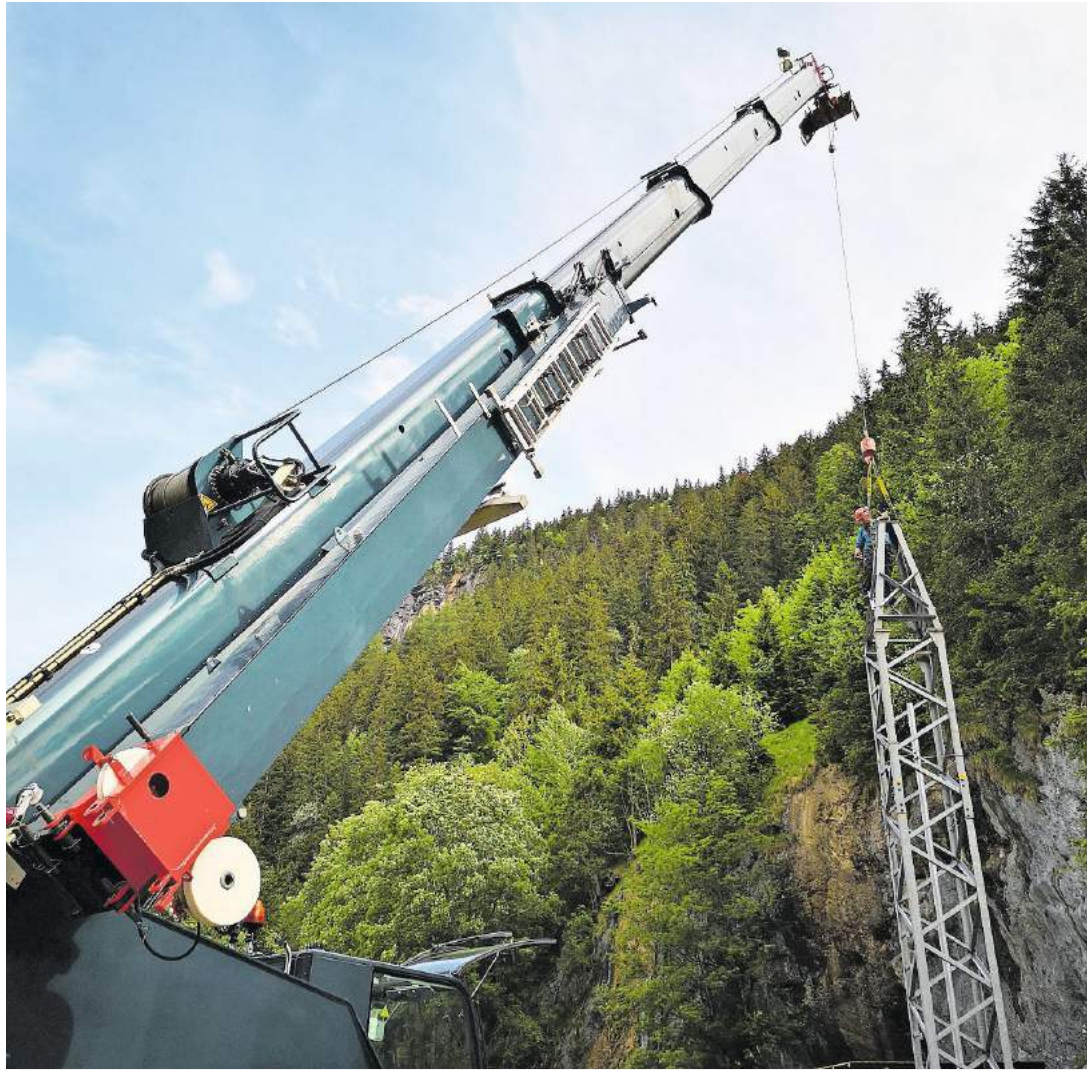
Der Ölbohrturm für das Stück Winnetou II wird mit einem Pneuroman auf der Engelberger Freilichtbühne aufgestellt.
